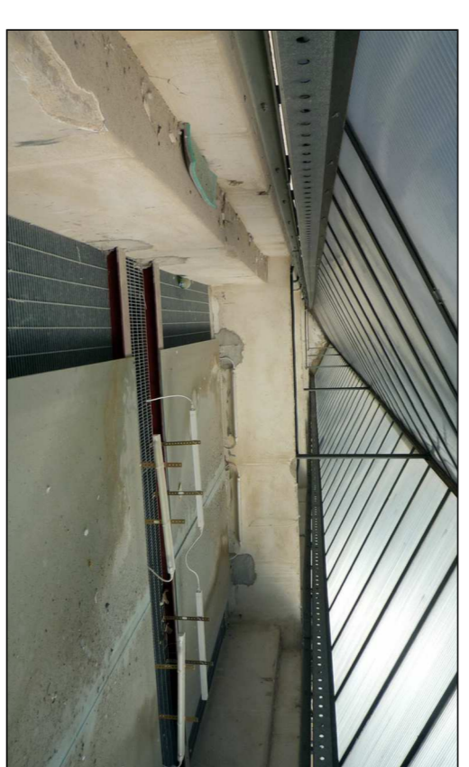
profili PER 100 di sostegno del sistema di controsoffitto
